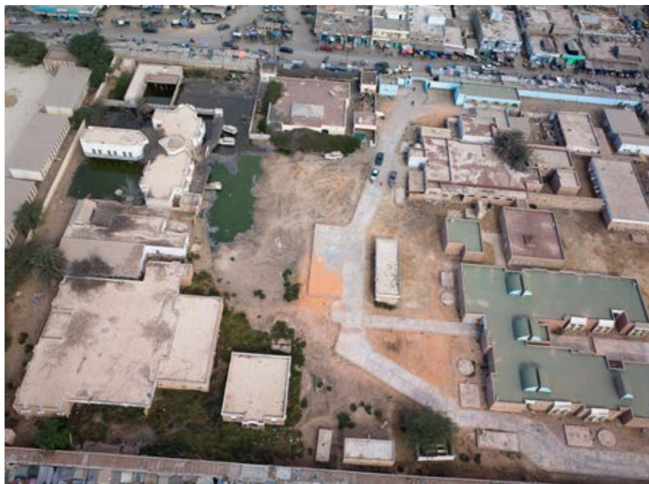
7 - Le centre de santé de Sebka est inondé depuis septembre 2013. (Février 2015)
