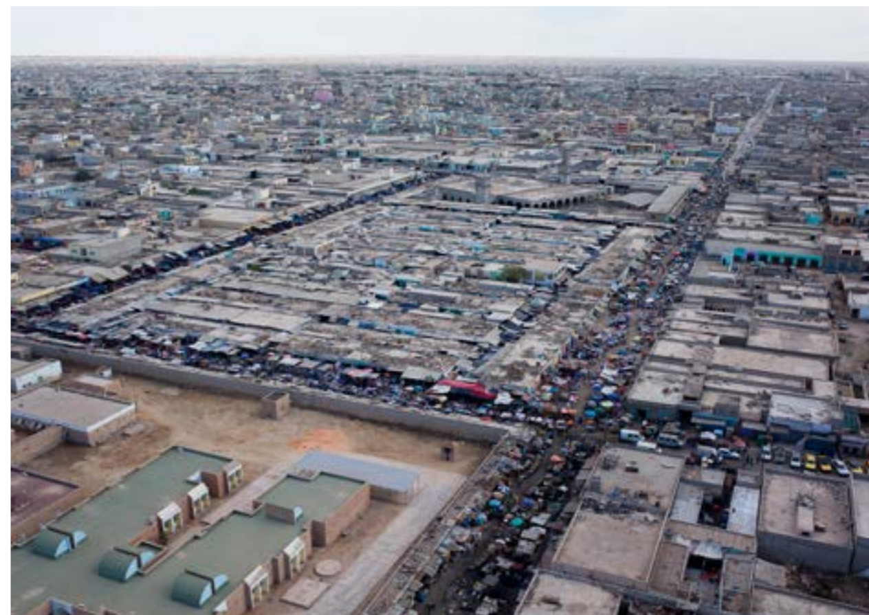
6 - Le Marché Cinquième, un enjeu économique important situé dans une zone exposée au risque d'inondation. (Février 2015)
