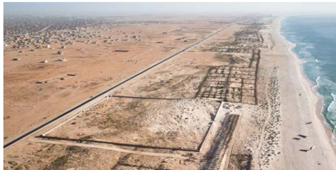
Cordon dunaire stabilisé par un dispositif de fixation et de protection au niveau de la commune de Sebkha, décembre 2014.
