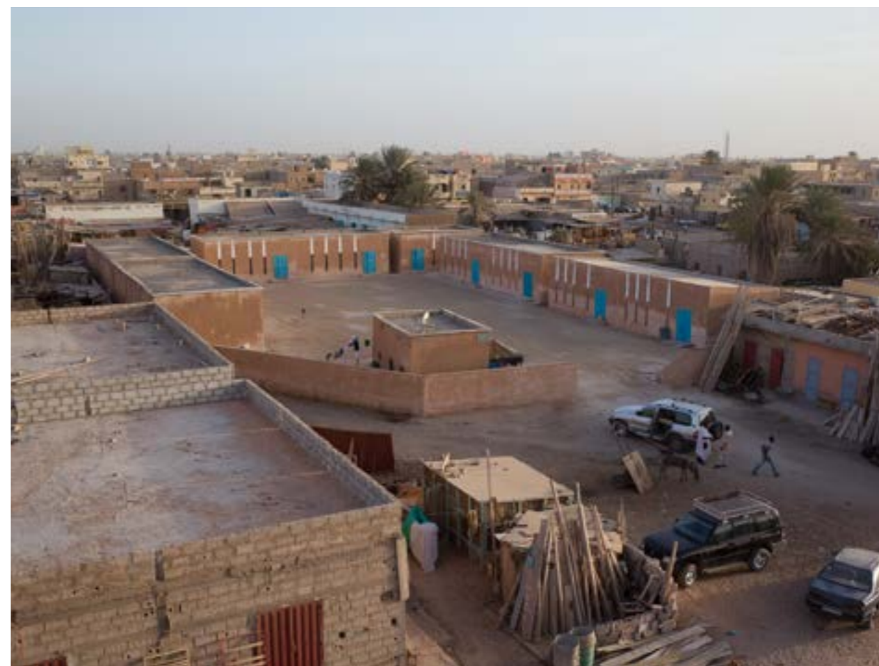
8 - Ecole 12, Quartier Cinquième, une zone régulièrement inondée. (Janvier 2015)
